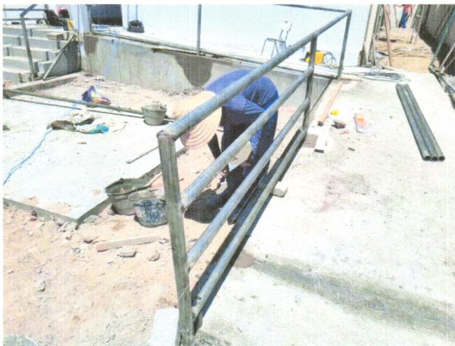
FOTO 18 – PINTURA DE ESTRUTURAS METÁLICAS (GUARDA-CORPO E TRAMA DE FERRO)
