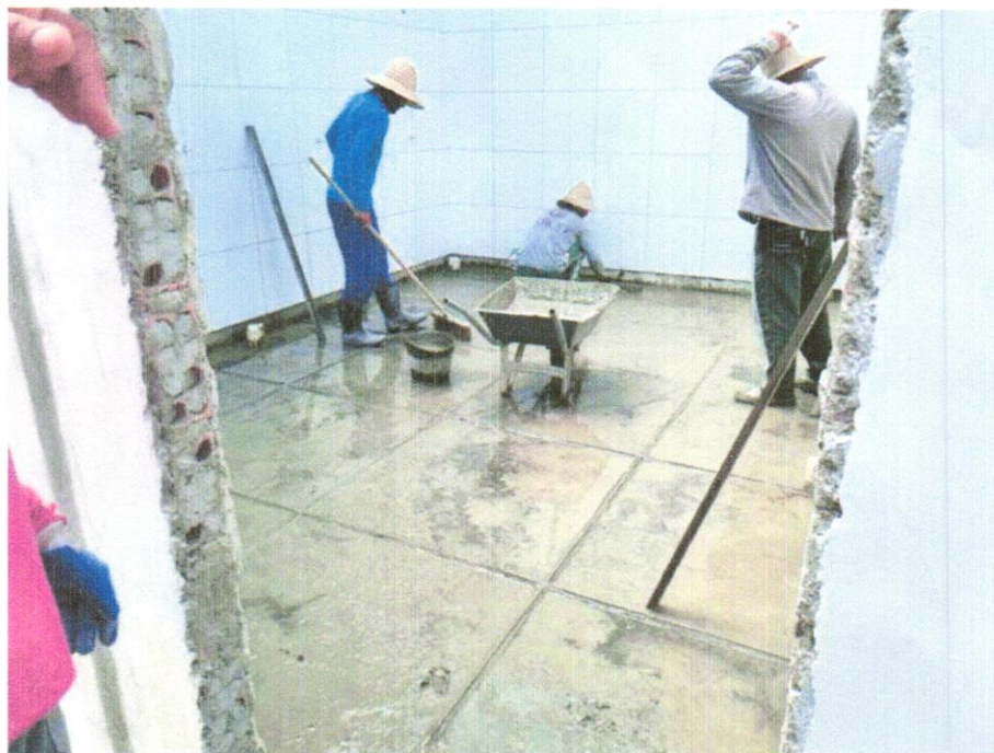
FOTO 04 – EXECUÇÃO DO PISO DE ALTA RESISTÊNCIA
