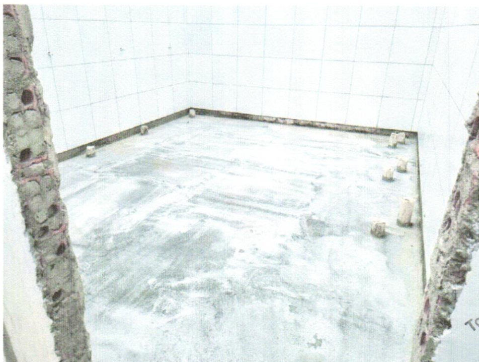
FOTO 04 – EXECUÇÃO DO PISO DE ALTA RESISTÊNCIA
