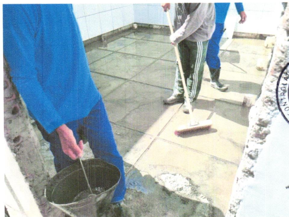
FOTO 02 - EXECUÇÃO DO PISO DE ALTA RESISTÊNCIA
