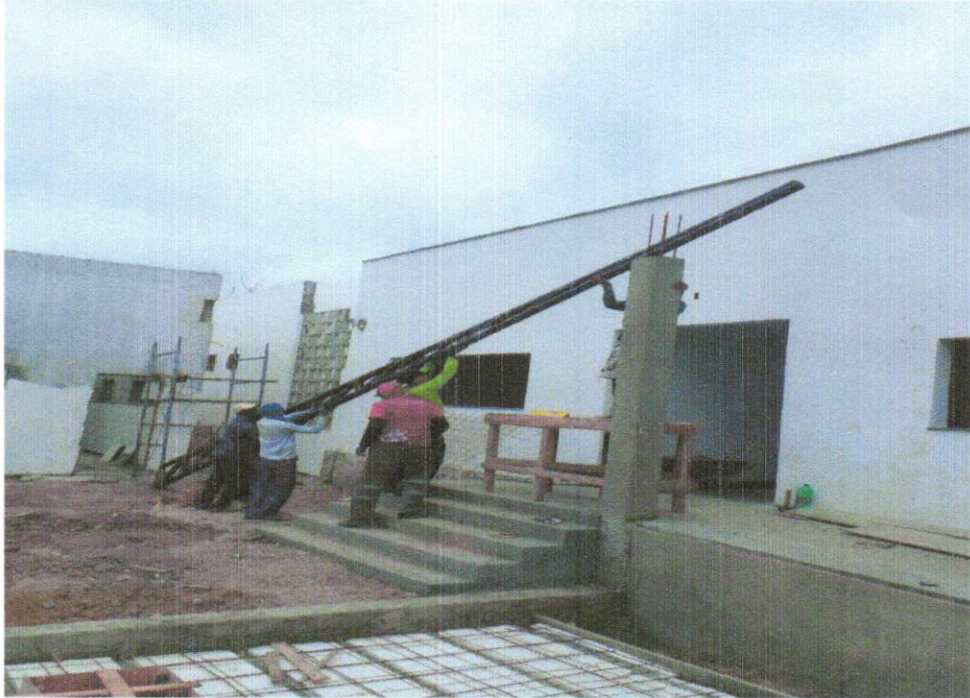
FOTO 10 – TRAMA DE AÇO PARA INSTALAÇÃO DE COBERTURA METÁLICA
