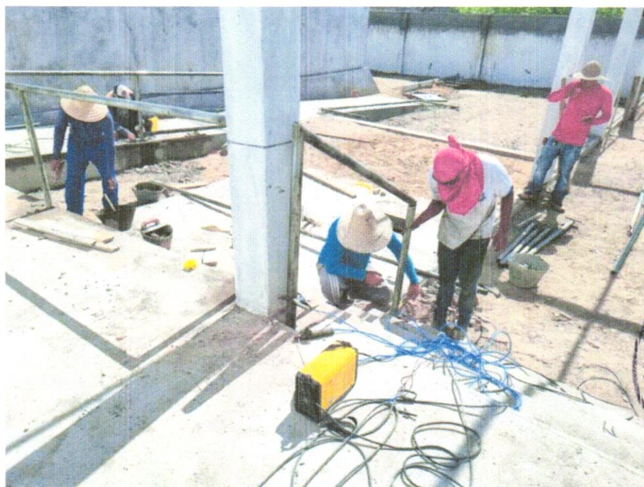
FOTO 16 – EXECUÇÃO DE GUARDA-CORPO
