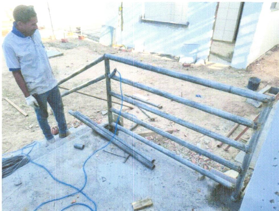
FOTO 16 – EXECUÇÃO DE GUARDA-CORPO
