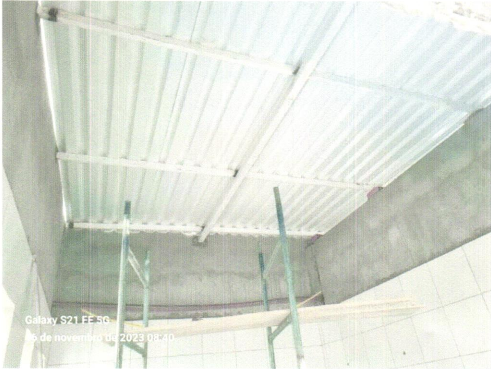
FOTO 14 – INSTALAÇÃO DE COBERTURA METÁLICA
