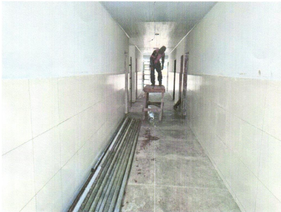
FOTO 24 – INSTALAÇÃO DE LUMINÁRIAS LED
