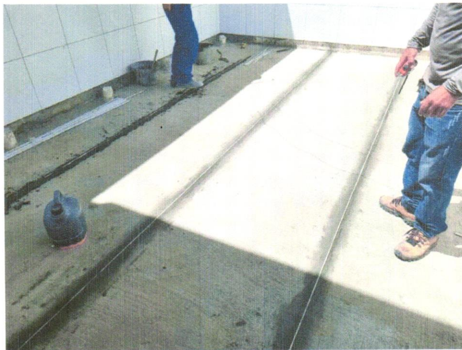
FOTO 02 - EXECUÇÃO DO PISO DE ALTA RESISTÊNCIA
