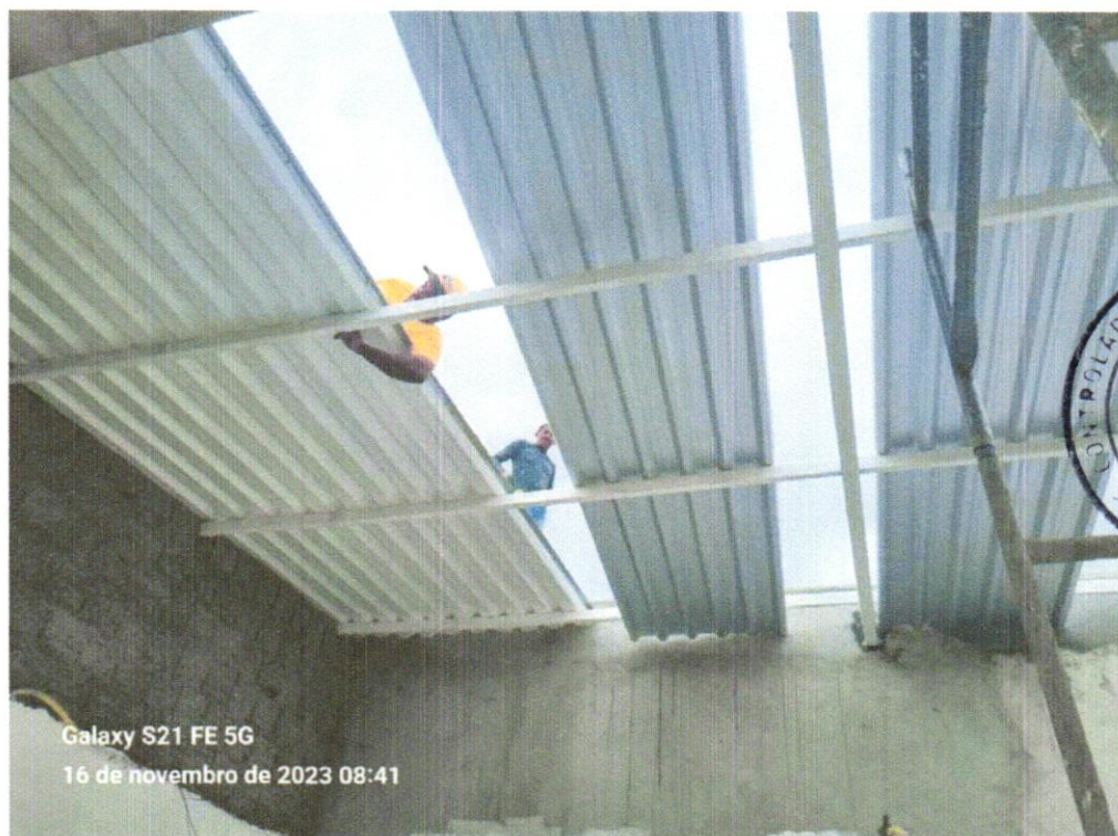
FOTO 12 – EXECUÇÃO DE COBERTURA METÁLICA
