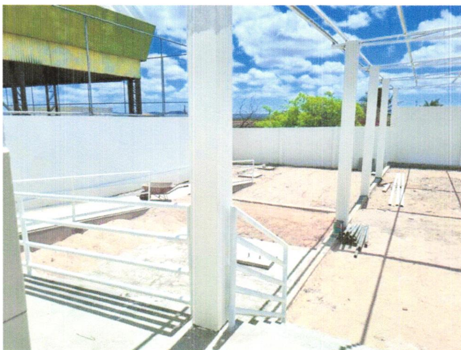
FOTO 18 – PINTURA DE ESTRUTURAS METÁLICAS (GUARDA-CORPO E TRAMA DE FERRO)
