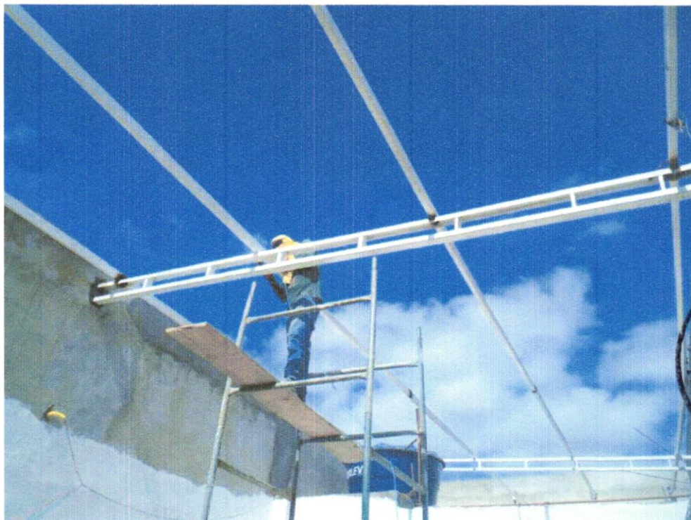
FOTO 10 – TRAMA DE AÇO PARA INSTALAÇÃO DE COBERTURA METÁLICA
