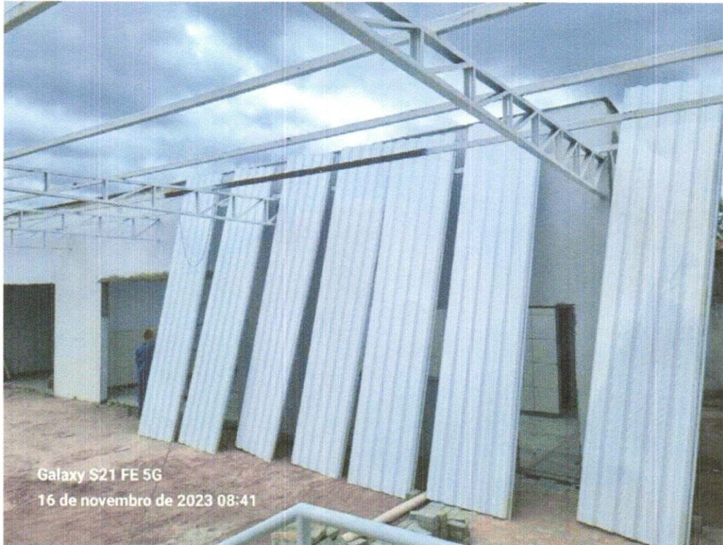
FOTO 12 – EXECUÇÃO DE COBERTURA METÁLICA
