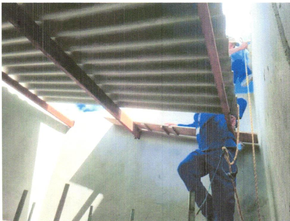
FOTO 07 – EXECUÇÃO DE COBERTURA DE FIBROCIMENTO
